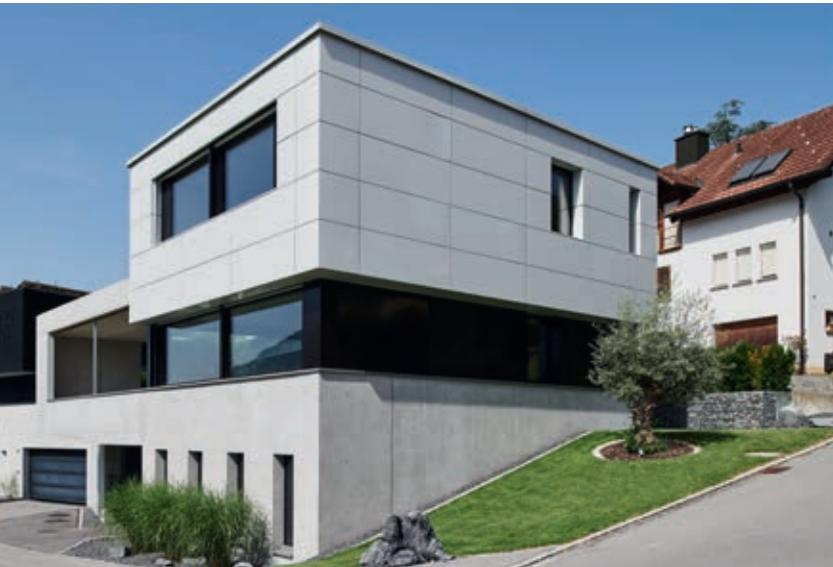
Roher Beton kennzeichnet die Fassade im Untergeschoss. Weisse Metallmehrschichtplatten machen die Front in den oberen Etagen aus.
